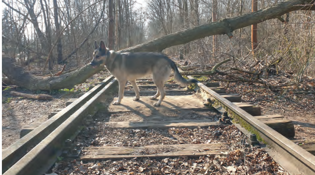
Zwischen „Zehlendorf-Süd“ und „Düppel“. Hier fuhren bis zum Reichsbahnerstreik im September 1980 S-Bahnen auf einem Stummelstück mit zwei S-Bahnhöfen. Die 3. Schiene ist die verfallene Stromschiene, die einst mit 750 V Gleichspannung 20 cm über der Trasse hängend montiert war
